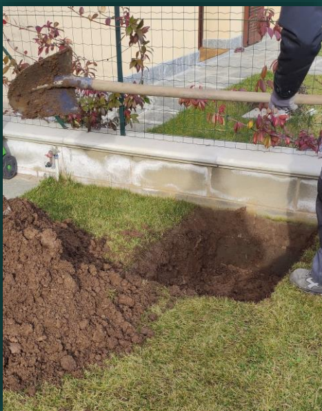
1. Scavo per accesso alla guaina
