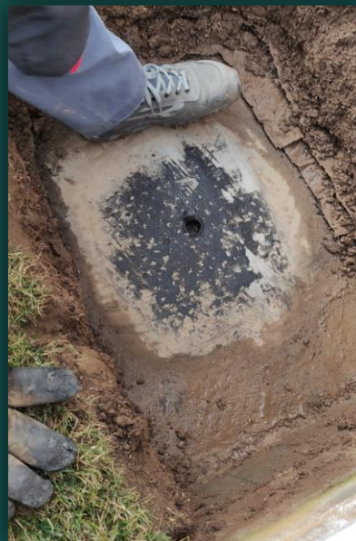
3. Formazione di forometria con analisi della guaina
