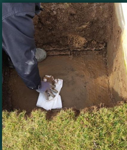
2. Guaina esistente tipo bituminosa
